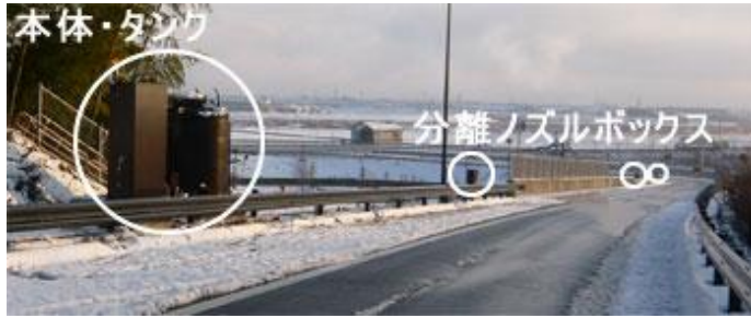
【オートカマグJET 分離ノズルタイプ設置状況】
