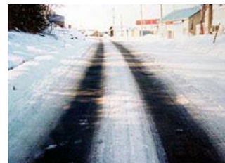
しみ出し部より約200mから350m先まで、引きずり効果により、サクサク路面に路面改質。
